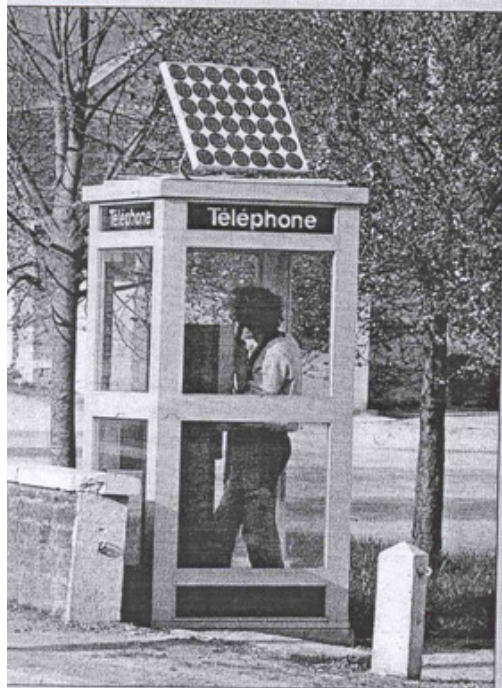
Photo 1 • Cabine téléphonique surmontée d'une batterie de photopiles.
